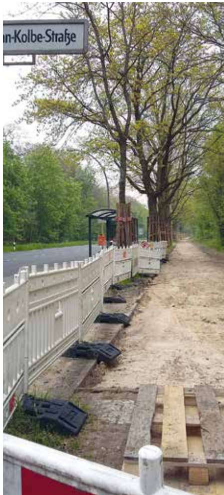
Baustelle Potsdamer Chaussee. Foto: Patrick Wolf
